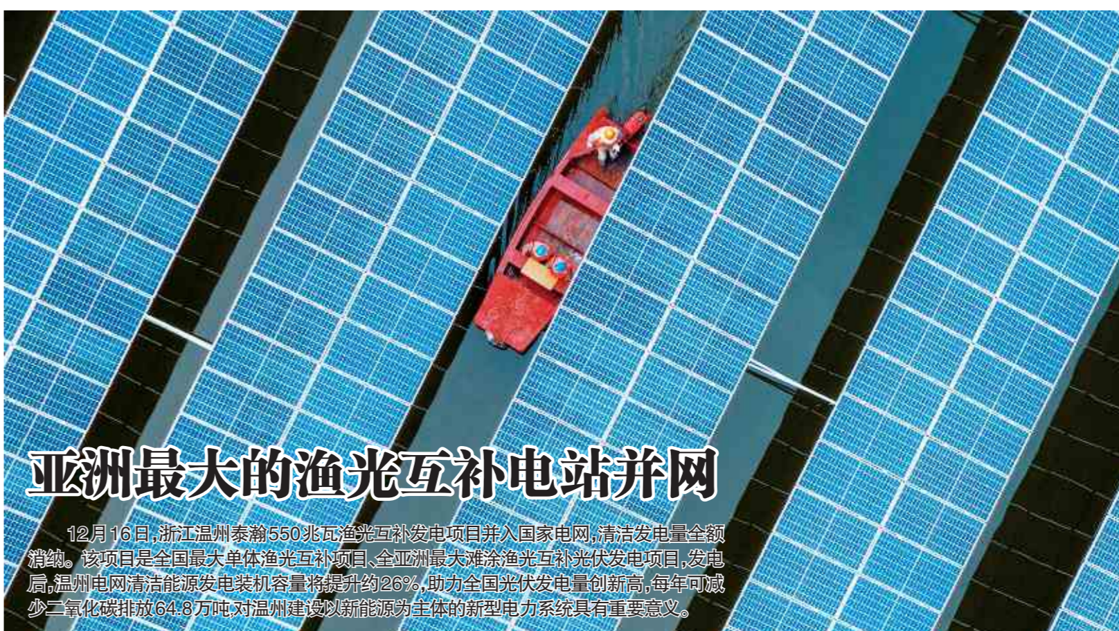
12月16日, 浙江温州泰顺550兆瓦渔光互补光伏发电项目并入国家电网, 清洁能源总量翻番。该项目是全国最大单体渔光互补项目, 全部采用大湖滩渔光互补光伏发电项目, 总装机150兆瓦, 清洁能源发电装机容量将约28%, 助力全国光伏发电量创新高, 每年可减少二氧化碳排放64.8万吨, 对温州建设新型能源体系、构建新型电力系统具有重要意义。
