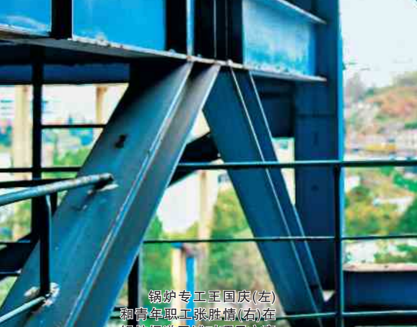
锅炉专工王国红(左)提前预检,张继伟(右)在锅炉区域对炉内管束再次核对。王国红 摄
